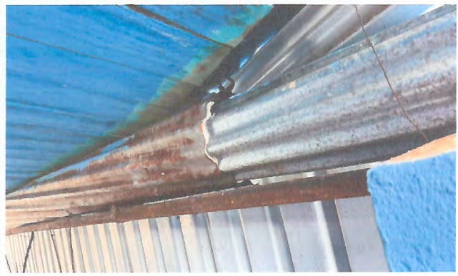
Foto 4: Canales y bajadas de agua.
