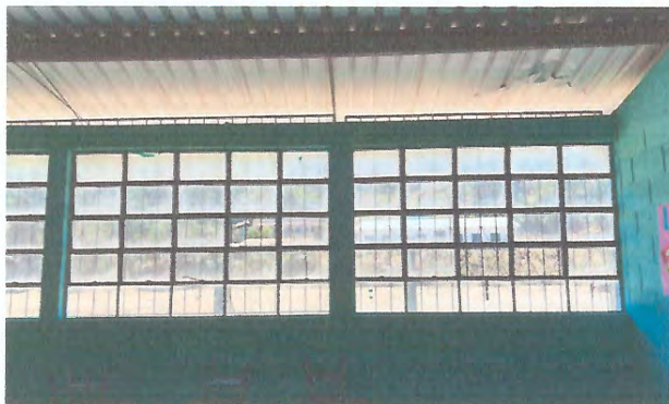
Foto 1: Cubierta de Lamina
