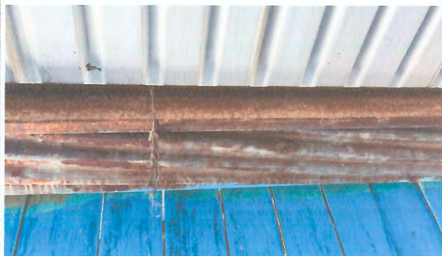
Foto 2: Estructura de Techo
